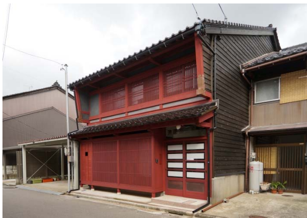
写真 2: 再生後の町家建築
